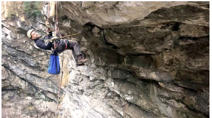
Bestens gesichert bei Felsräumungen in der Rappenlochschlucht in Dornbirn.
