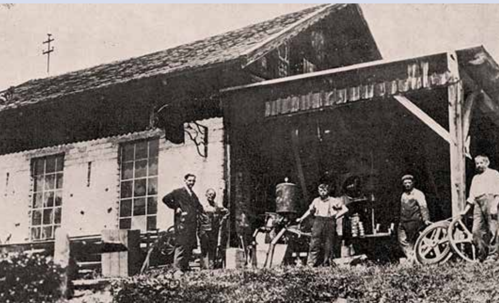
Werkstätte um 1934: im Vordergrund einige Antriebsräder sowie eine Steurer Güllepumpe auf dem Prüfstand, links auf dem Bild Sohn Ing. Johann Steurer
