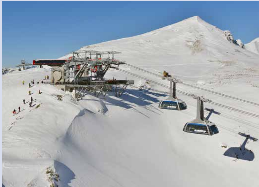
Pendelbahn Arosa-Lenzerheide, mit Kabinen für 150 Personen, die größte von der Fa. Steurer gebaute Anlage
