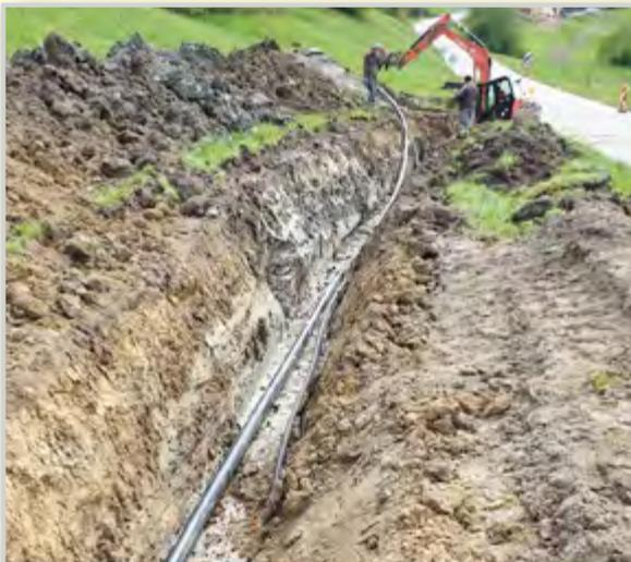
Es wurden 3,50 km Transportleitung (PE-DN110), der Übergabeschacht in der Parzelle Standbach und ca. 650 m Hausanschlussleitungen bis zur Wassergenossenschaft in Thal gegraben bzw. verlegt.
